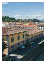
pp. 354 Veduta aerea dell'Innovation Center di Fondazione CR Firenze
